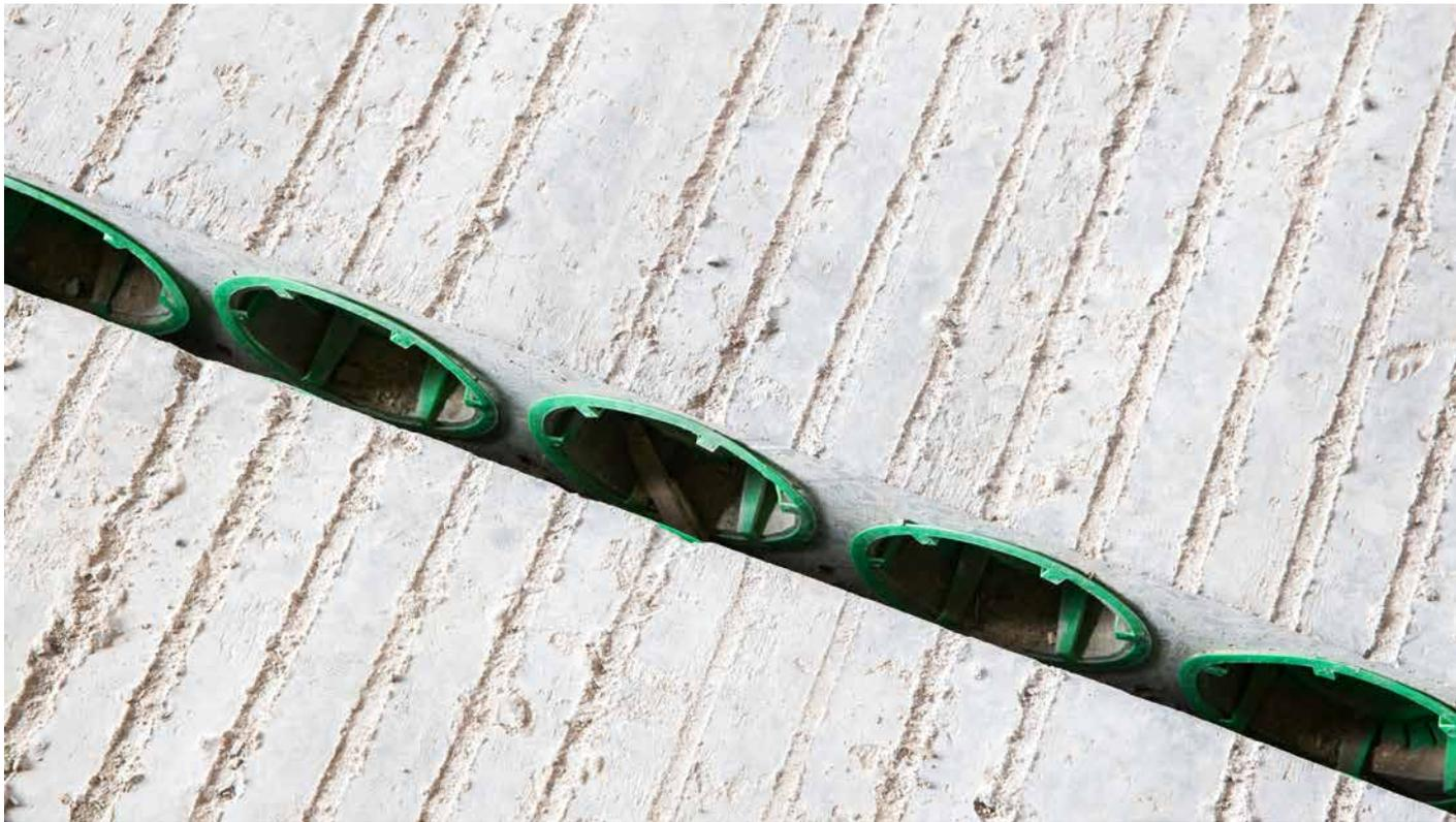
Les pièces d'appoint sont pourvues d'**ancres à queue d'aronde (a)**, qui doivent toujours être manipulées avec l'**ancrage de transport à anneaux (b)** correspondante.
